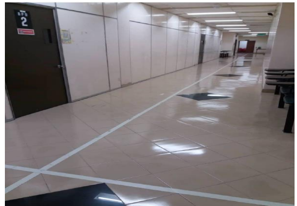
Lantai yang bersih, selamat dan tidak rosak
